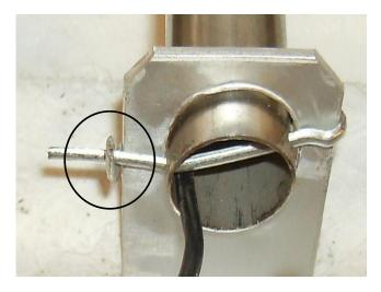
Use pliers to twist and lock the pin. Make sure the pole is locked well and cannot turn. (Dùng cái kềm để khóa cái pin lại như trong hình. Phải lock kỹ để ống innox không được xoay)
